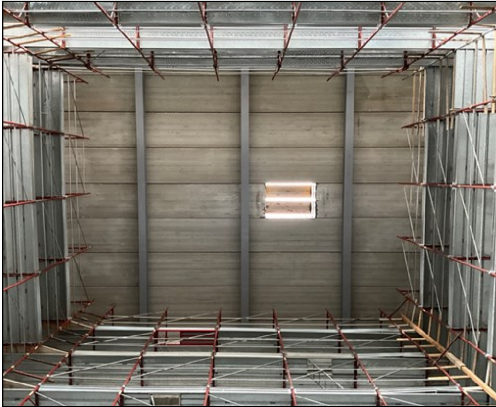
Figura 6: rilievi fotografici (vista Torre Scenica, stato attuale)
